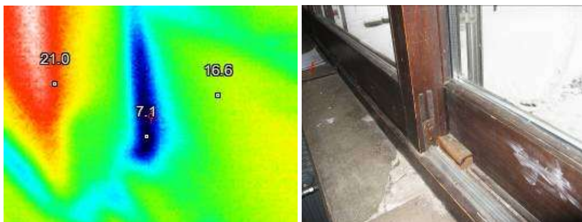
Slika 16: Izgube toplote na spojih oken 2 (OŠ A.T. Linharta Radovljica)
